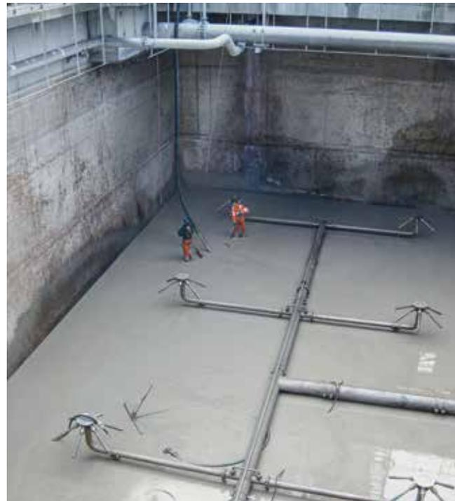
Sauerstoffeintragssystem im Belebungsbecken der Gebr. Lang GmbH Papierfabrik in Ettringen. Die sechsstrahligen Ejektoren werden mit gasförmigem Sauerstoff aus einer stationären Tankanlage versorgt.
